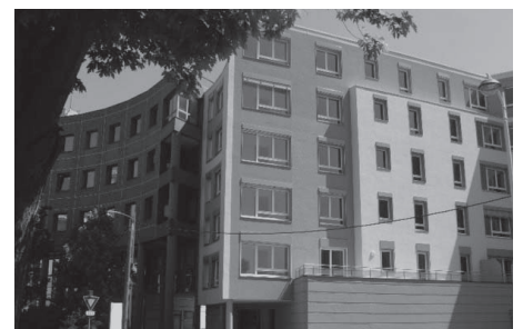
Ambroise Croizat : le premier immeuble basse consommation en Rhône-Alpes
